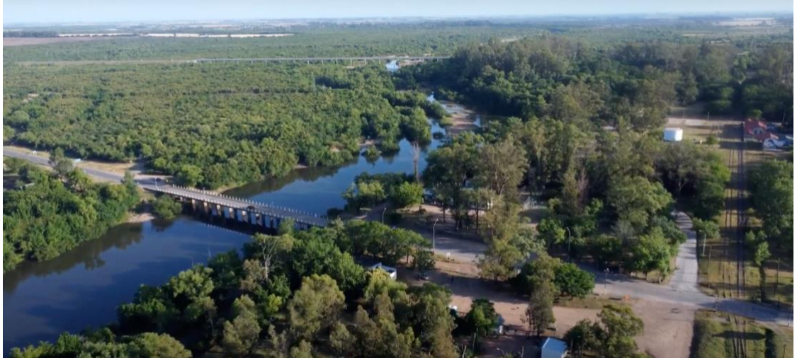
Vista aérea del “puente viejo” en la ciudad de Santa Lucía
